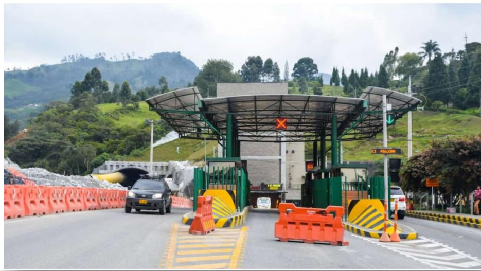
Figura 1 Túnel de Occidente. Departamento de Antioquia, 2023.
