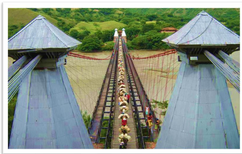
Figura 18 Puente de Occidente. Municipio de Santa fe de Antioquia, 2023.
