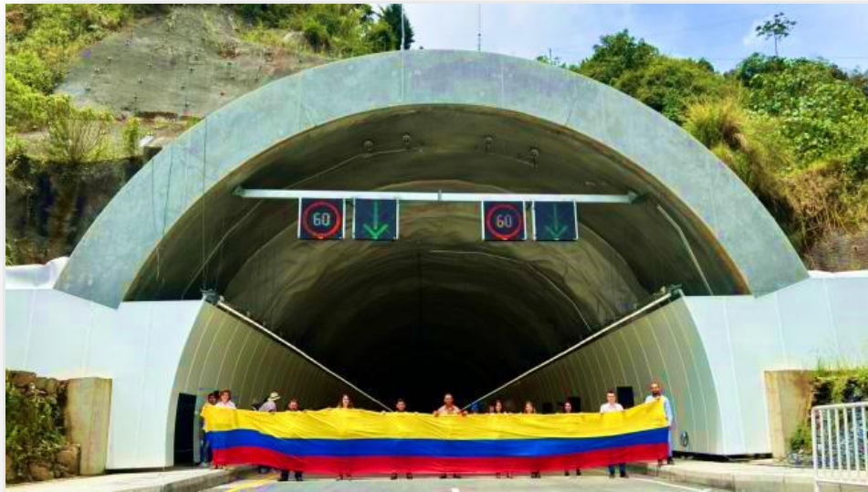
Figura 2 Túnel de Occidente 2. Departamento de Antioquia, 2023.
