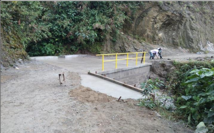
obra de drenaje vía el placer
