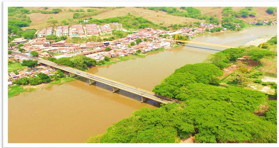
Figura 10 Construcción Concesion La Pintada – Antioquia, 2023
