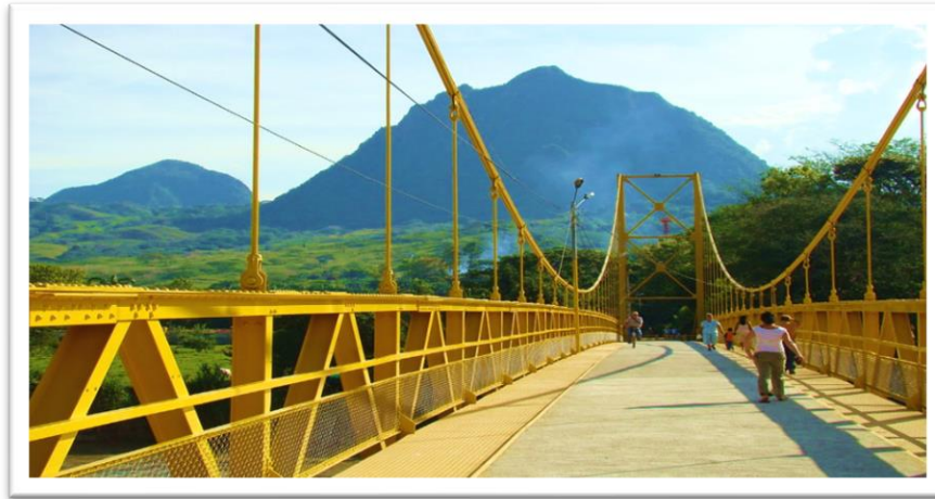
Figura 9 Puente Colgante Viejo. Municipio de La Pintada – Antioquia, 2023
