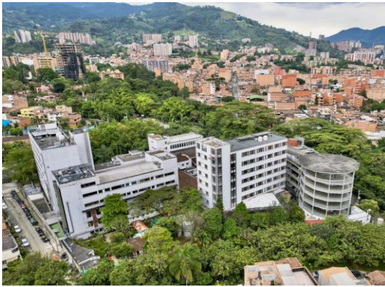
Foto panorámica de la E.S.E HMUA.
