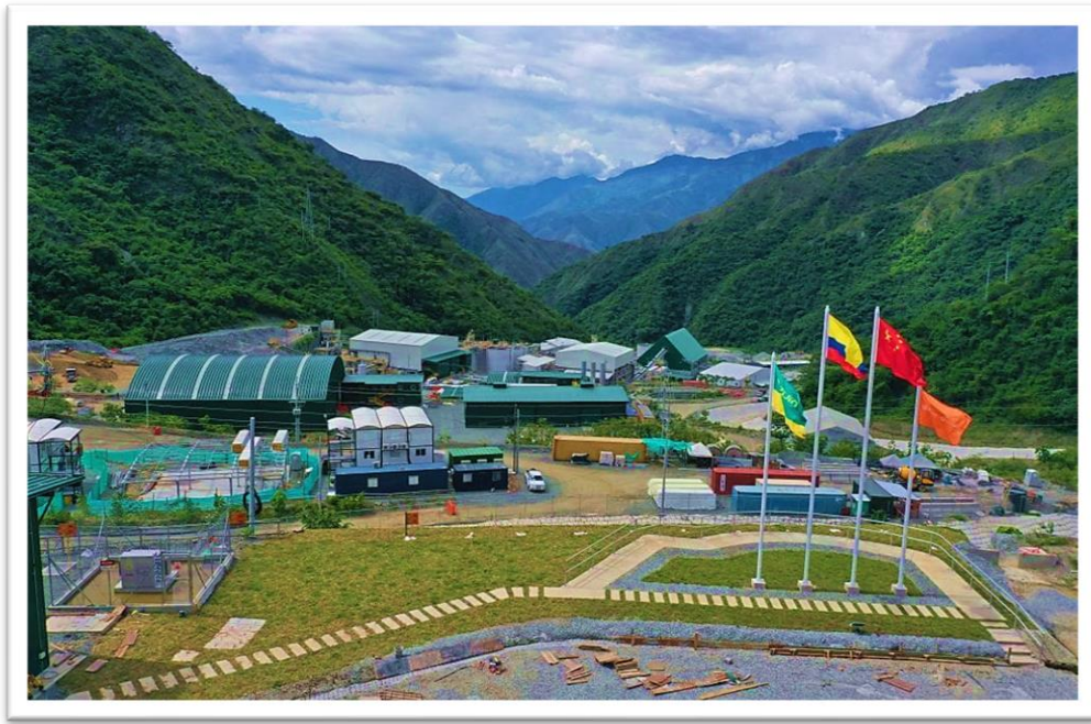
Figura 3 Instalaciones mina de Oro. Municipio de Buriticá – Antioquia, 2023.
