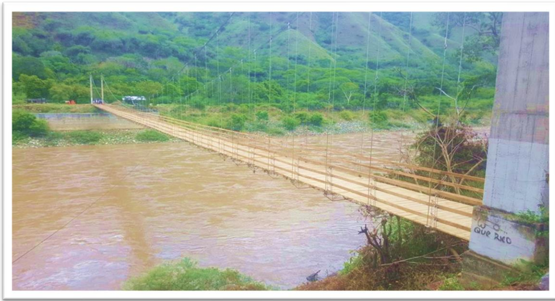
Figura 7 Puente sobre el río Cauca. Vereda la Angelina, Municipio de Buriticá – Antioquia, 2023
